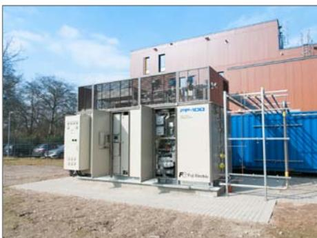
Die neue brennstoffzellen-Anlage am ZBT. © UDE
