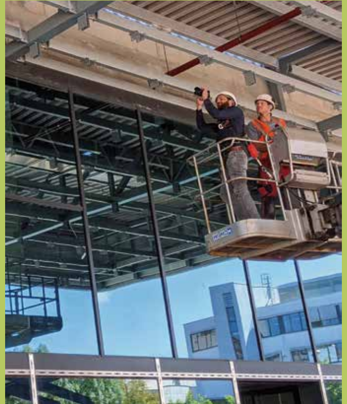
Safety first: Bauseitige Kontrolle von Schraubenverbindungen
