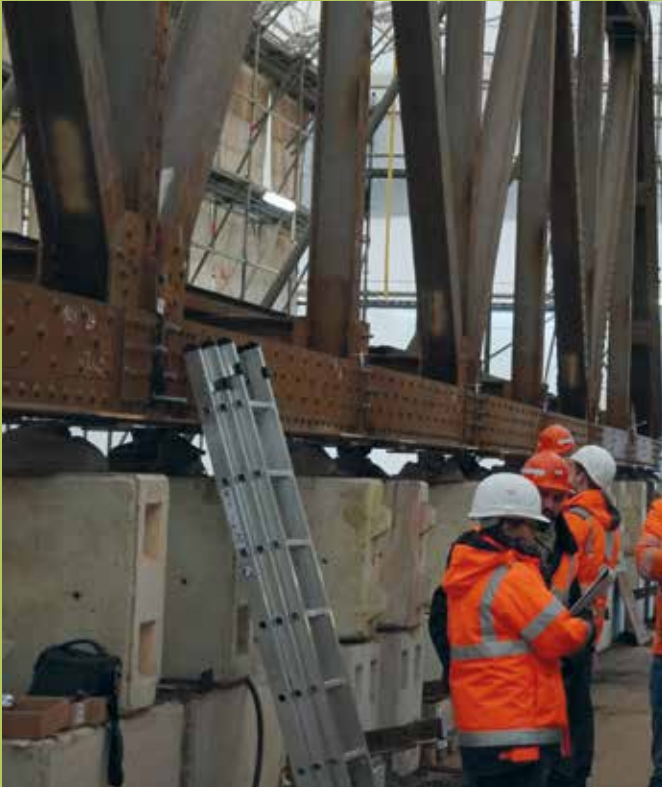
Geschichte erhalten: Begutachtung einer genieteten denkmalgeschützten Eisenbahnbrücke
