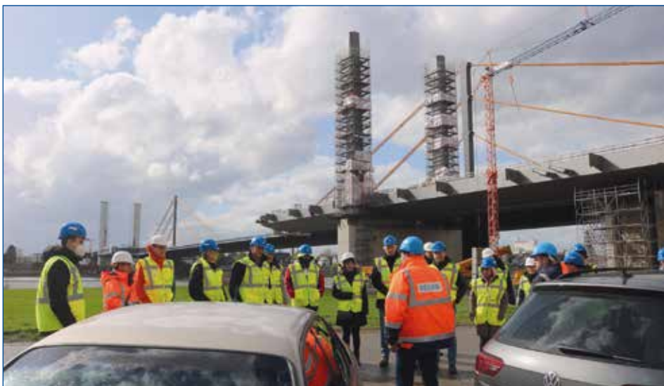
Bei echtem Aprilwetter lernten die Teilnehmenden die Baustelle der neuen Rheinbrücke kennen
