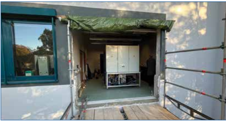
Vorher musste ein 3 x 3 Meter großes Loch in die Außenwand geschlagen werden
