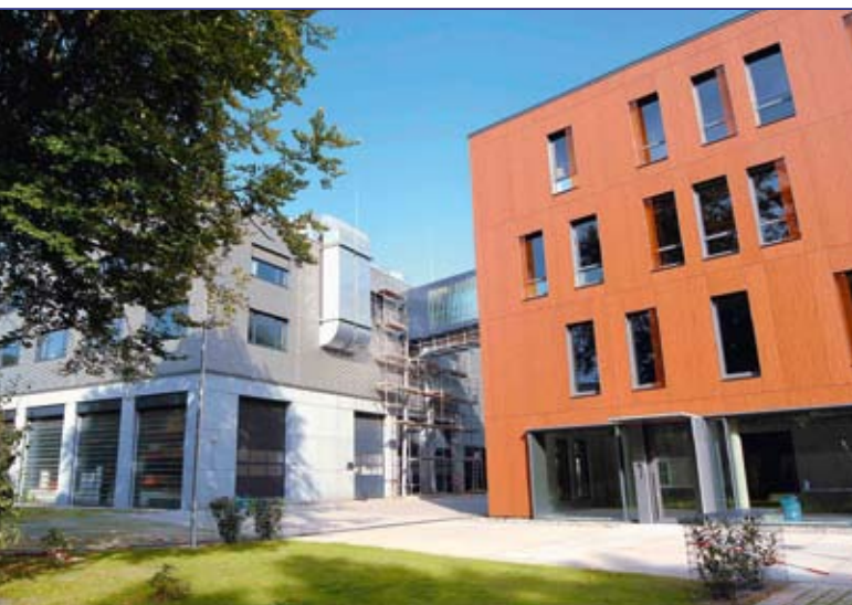
Zukunftssicher: Das ZBT mit dem neuen Erweiterungsbau (rechts)
