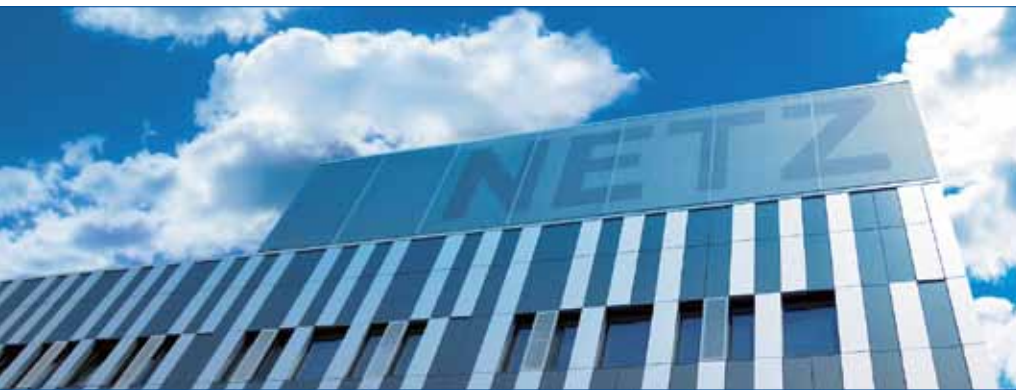
Hinter der NETZ-Fassade verbergen sich 66 Büros, 36 Labore, eine Syntheseanlage und ein Mikroskopiezentrum (Foto: UDE)
