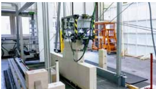
CABLAR-Roboter mit modularisiertem Greifer zum automatisierten Errichten einer Mauer
