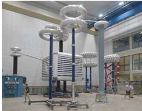
Prüfung der elektrischen Eigenschaften eines Mess-teilers für eine 500-kV-HGÜ-Konverterstation
