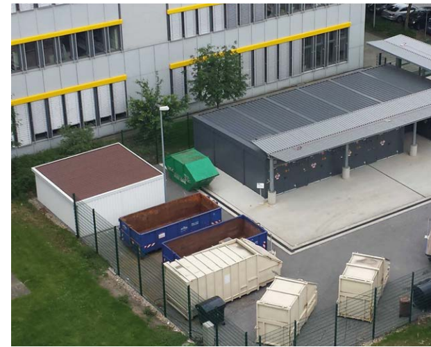
Der zentrale Entsorgungshof am Campus Essen bietet genügend Platz, um Restmüll getrennt von anderen Abfallfraktionen zu sammeln.
